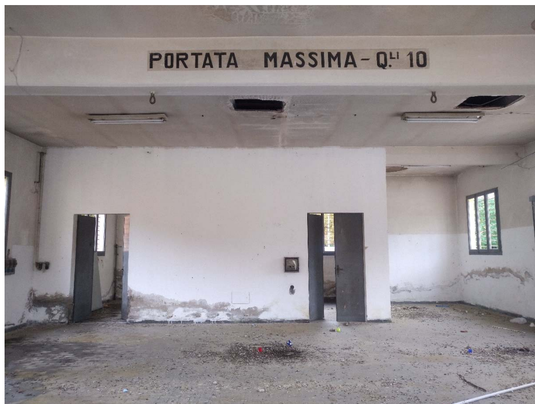
“Ex Centrale Termica Lavanderie”: vista interna
