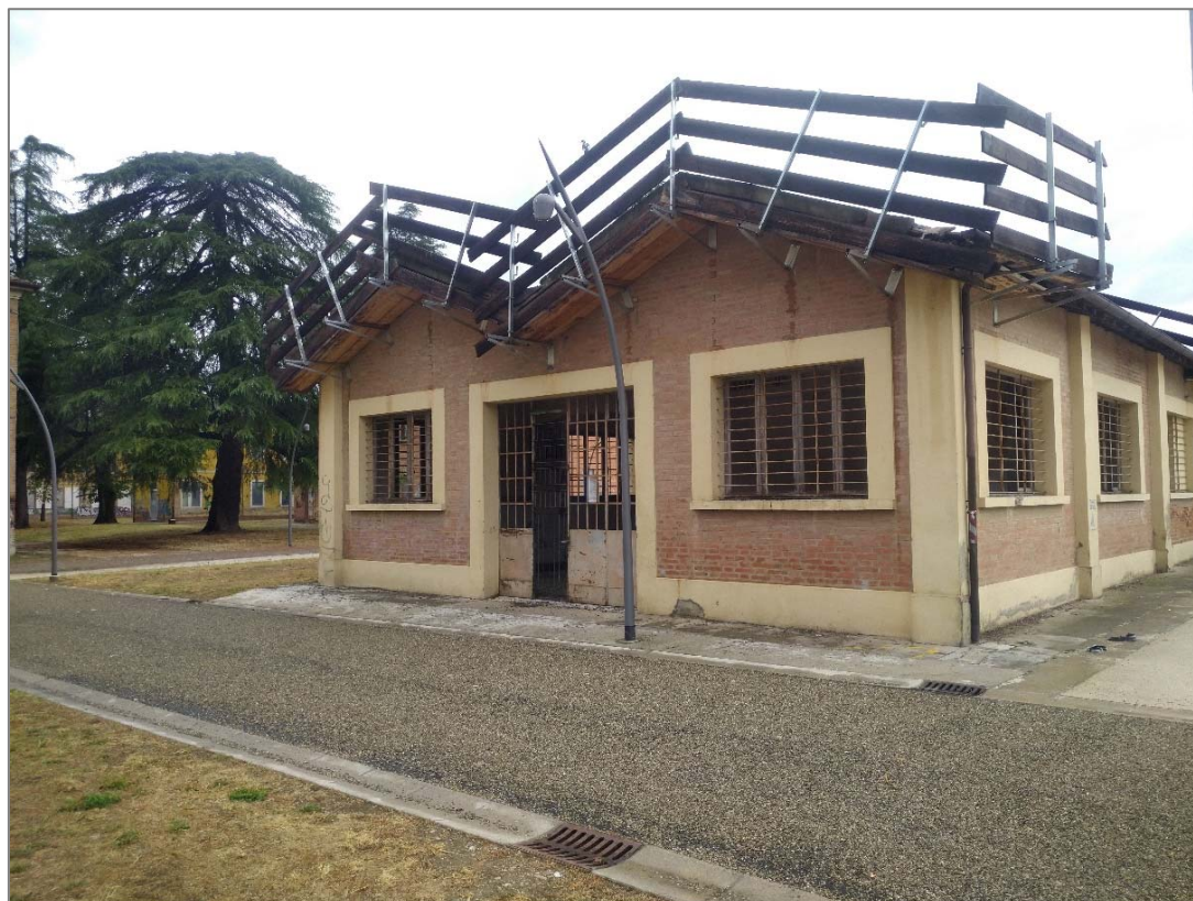
“Ex Centrale Termica Lavanderie”: vista esterna
