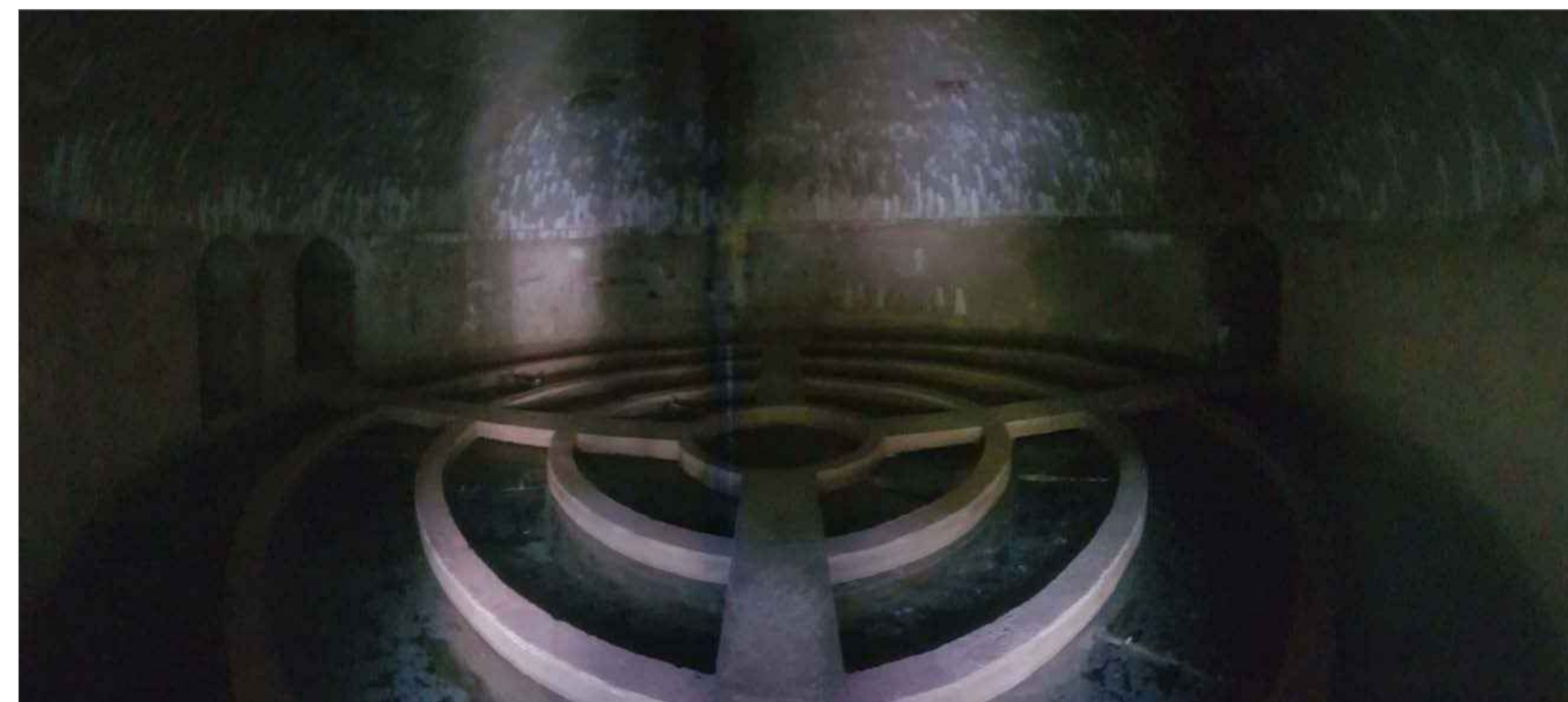
2 - Interno settecentesco dell'acquedotto
