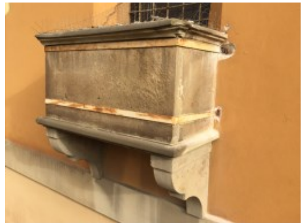
Dettaglio dei balconi in arenaria da restaurare
