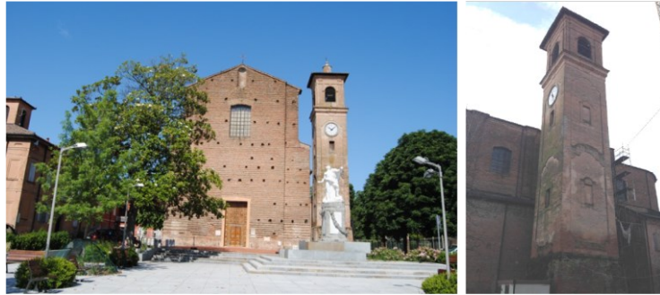
immagini dell'esterno dopo il sisma
