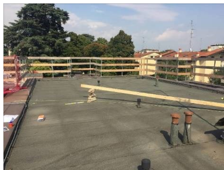
Il tetto prima dei lavori
