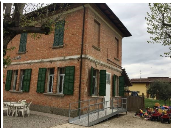
la rampa per accesso disabili
